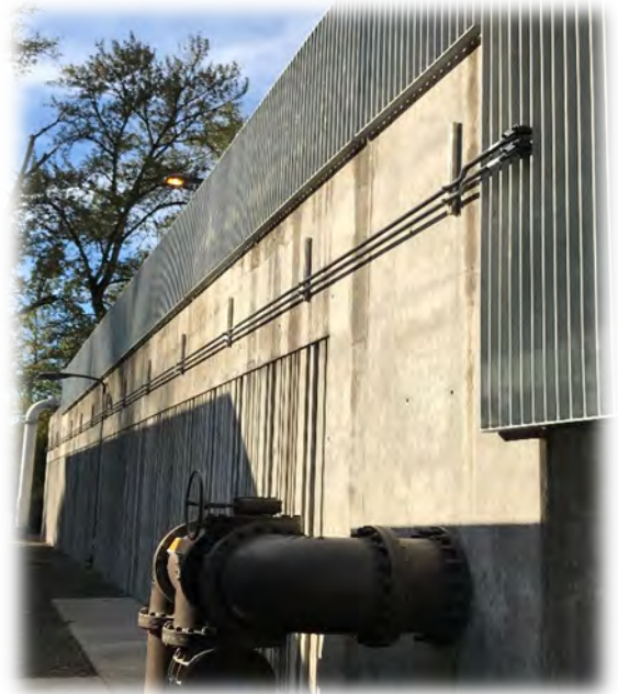
2) Conduit installation
